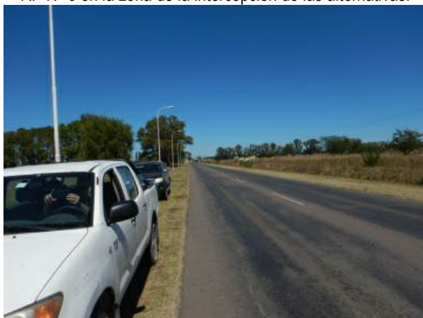
RP N° 200 en la zona de la intercepción de las alternativas.
