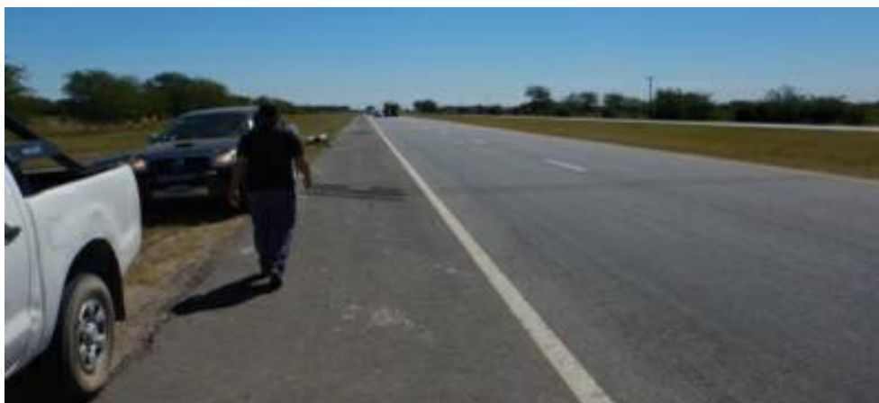
P Nº 6 en la zona de la intercepción de la traza de la alternativa blanca.
