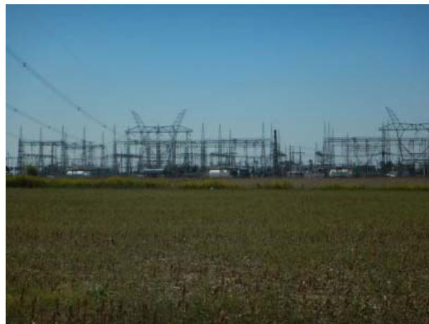
Tramo agrícola (maíz) de ingreso a la ET Ezeiza sobre la traza de la alternativa.
