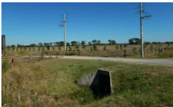
Vista hacia futura ET Plomer desde RP N° 6.
