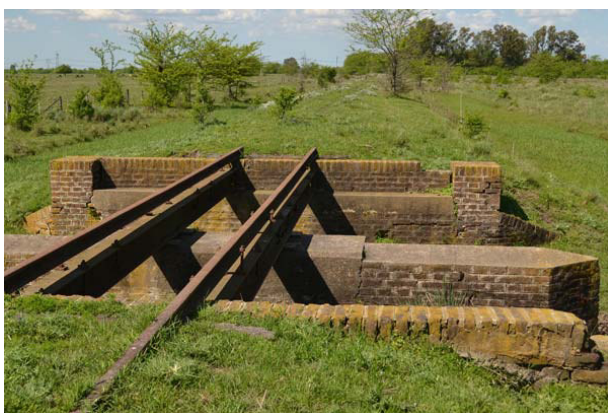
Restos del antiguo terraplén del FC Midland, en zonas próximas al trazado de la alternativa.
