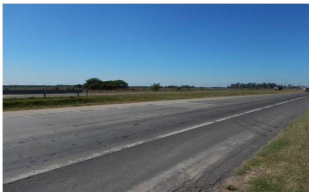
RP N° 6 en la zona de la intercepción de las alternativas.
