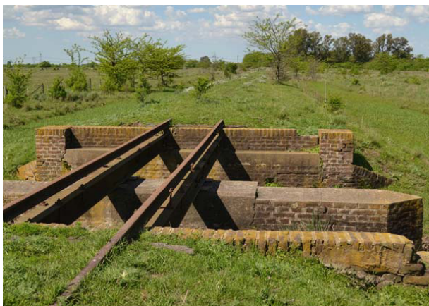
Restos del antiguo terraplén del FC Midland, en zonas próximas al trazado de la alternativa.
