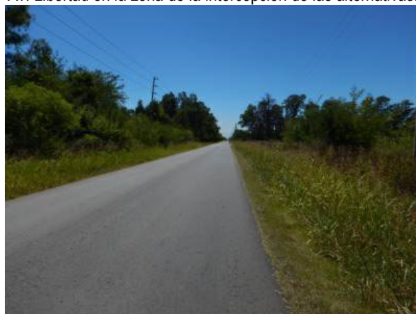
Camino de acceso a la Cárcel de Marcos Paz en la zona de la intercepción de las alternativas.
